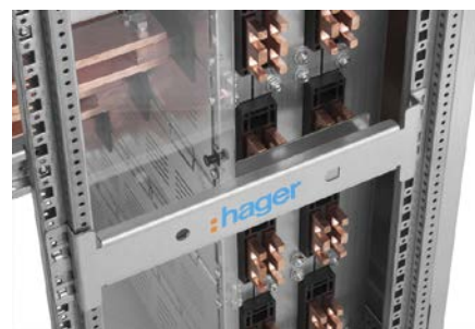
Einsatz des U-MH80 zum einfachen Positionieren der Sammelschiene
