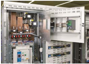
Komponenten des aktiven Störlichtbogen-Schutzsystems
