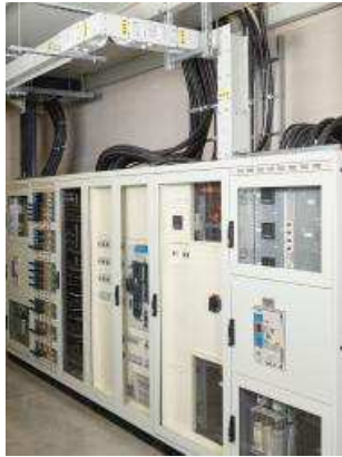
Anbindung unibar H an unimes H
