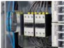
Anschlussbaugruppe zur Wandlermontage bei Eigenstrommessung für Wartungs- und Sicherheitskonzept. Die Zuleitungskabel werden direkt waagrecht an den Sammelschienen mittels Schrauben M12 angeschlossen.
