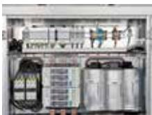
Vorgefertigte und vorverdrahtete Steuerungsbaugruppe verringert den Verdrahtungsaufwand
