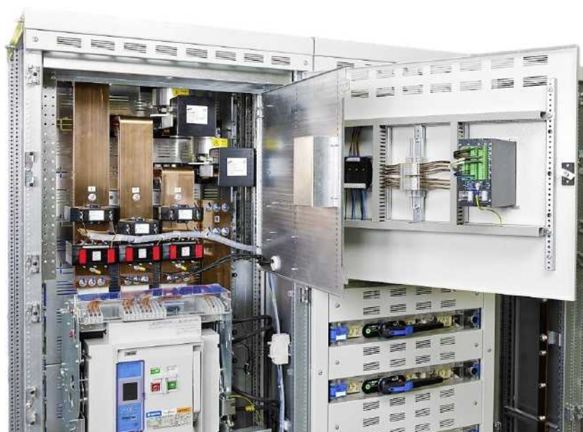
Leistungsschalterfeld mit Kurzschliessereinheit.
