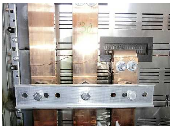
Auswirkungen mit einem aktiven Störlichtbogen-Schutzsystem.
